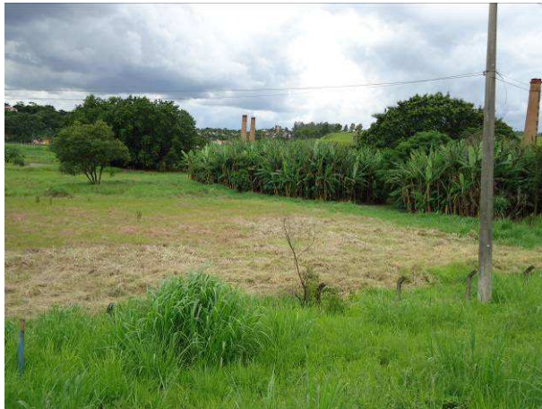
Figura 9. Área que recebia resíduos da construção civil no município de Vinhedo.
